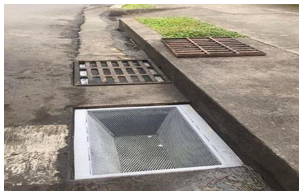
Rajah 2.2 : Jenis Perangkap sampah yang dipasang pada longkang
